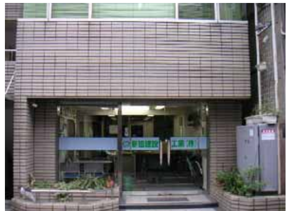
新協建設工業株本社外観
