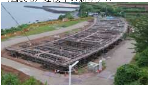
（図表2）建設中の新ホテル
