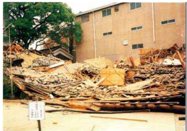
(図表4) 倒壊した「沢の鶴資料館」
