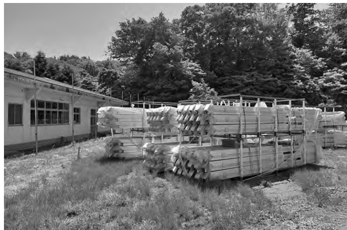
図表13 廃校のグラウンドに設置工事中の太陽光発電設備
