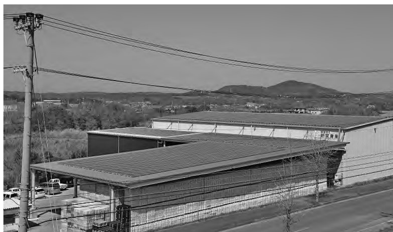
図表18 巨大冷蔵庫の屋根に設置された太陽光発電パネル
