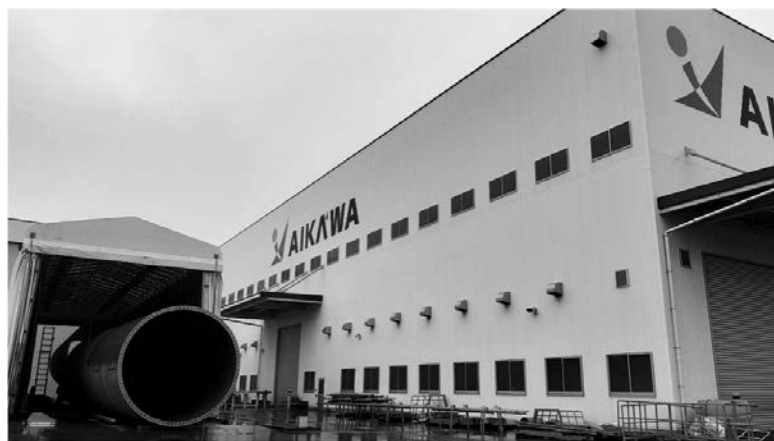
図表6 タワー専用工場（全景）
