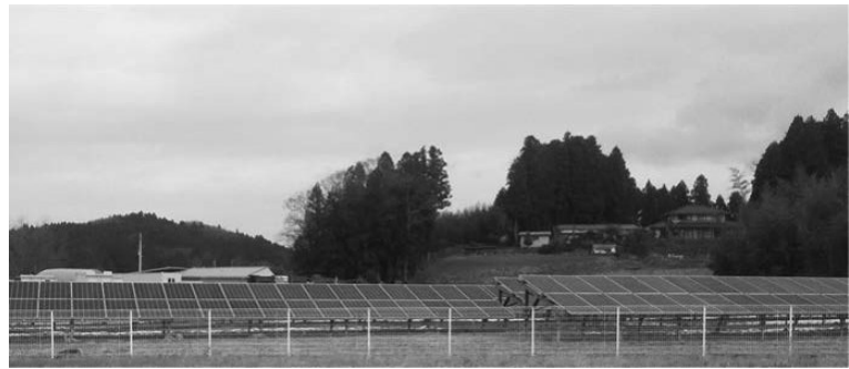
図表2-3-4 岩法寺太陽光発電所
