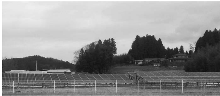
図表2-3-4 岩法寺太陽光発電所
