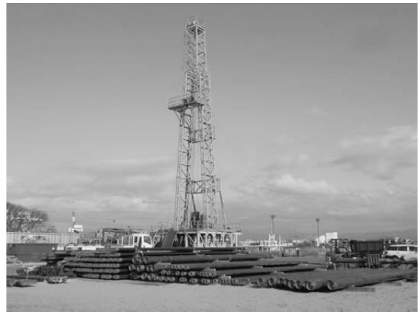
図表3 さく井工事（新潟県）
