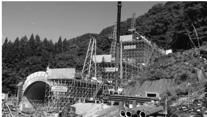
② 特殊土木工事（山形県）
