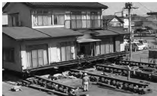
図表8 曳家工事の様子
