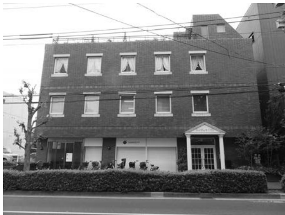
図表28 同社が入居する建物の外観
