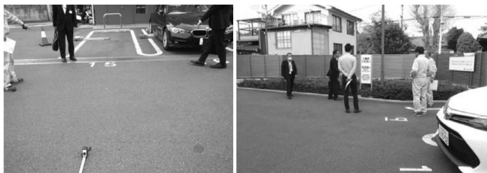
図表5 設置工事の風景
