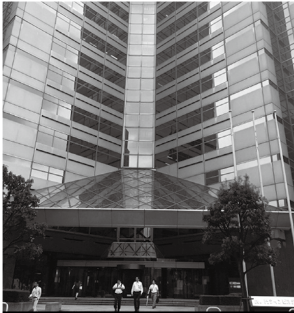
図表9 独立行政法人石油天然ガス・金属鉱物資源機構
