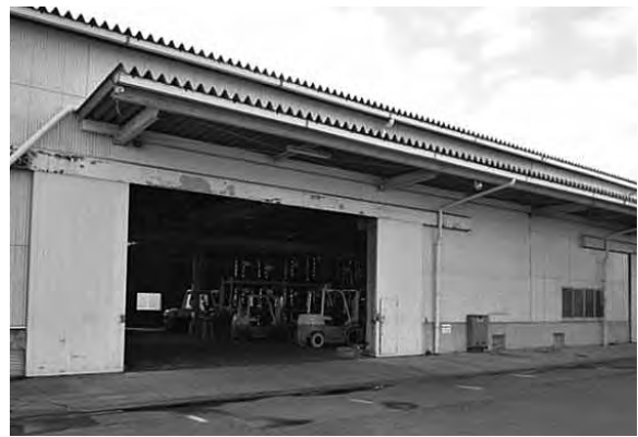
図表8 大型機械搬送に対応できる倉庫設備等
