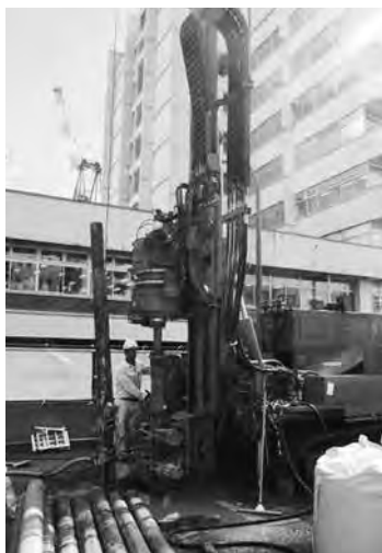
図表18 地中熱利用設備工事施工状況
