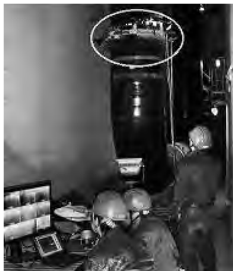
図表11 点検用ロボット「のぼるくん」による作業風景
