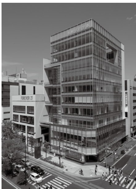
図表4 新本店ビル外観
