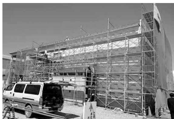
図表8 建設中の新本社
