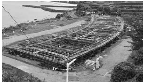
図表11 建設中の新ホテル
