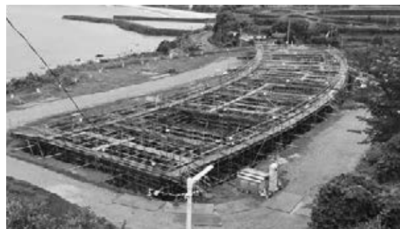
図表11 建設中の新ホテル
