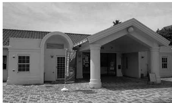
図表11 「hinode」外観（正面玄関）
