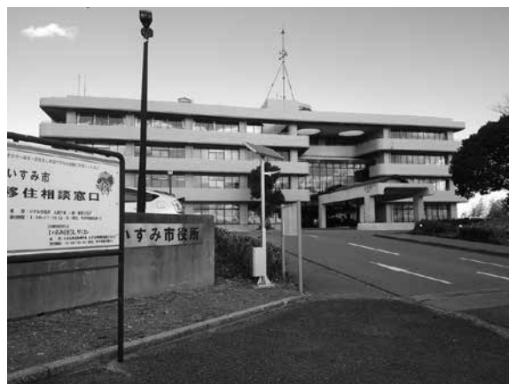
図表13 いすみ市役所全景
