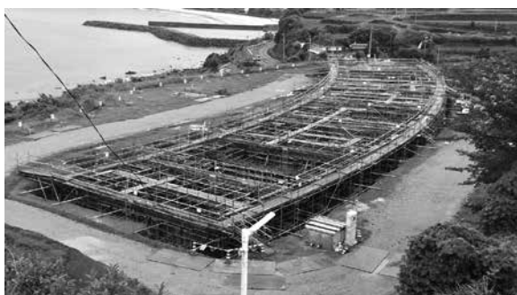
図表2 建設中の新ホテル
