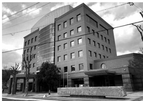
図表8 諏訪信用金庫 外観
