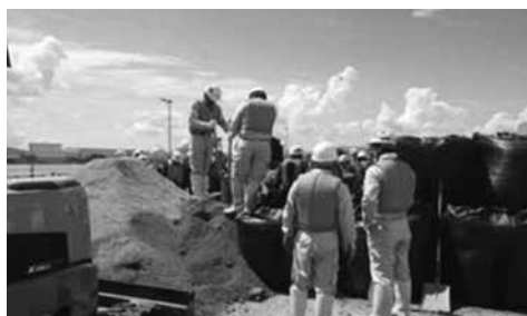
図表10 大型土のう作成・配置現場
