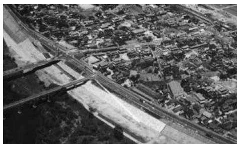
図表9 高梁川復旧工事現場
