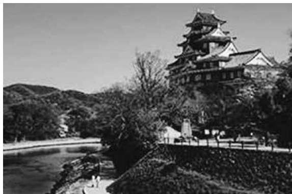
図表7 旭川丸の内水辺整備工事
