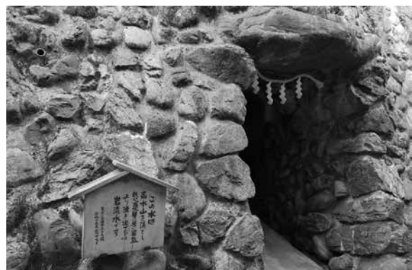
図表17 秩父古生層の岩盤を掘り抜いた横井戸
