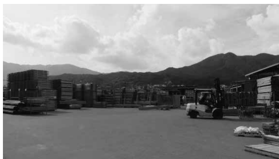
図表15 レンタル用仮設機材置き場
