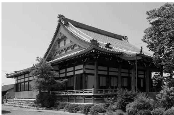
図表27 最近の改修事例
