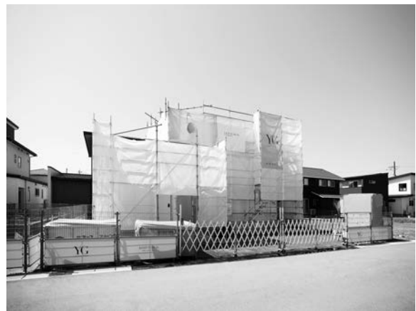
図表20 建築現場例
