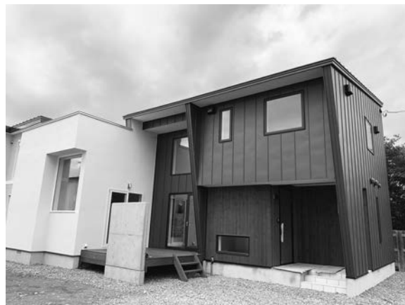
図表16 施工事例
