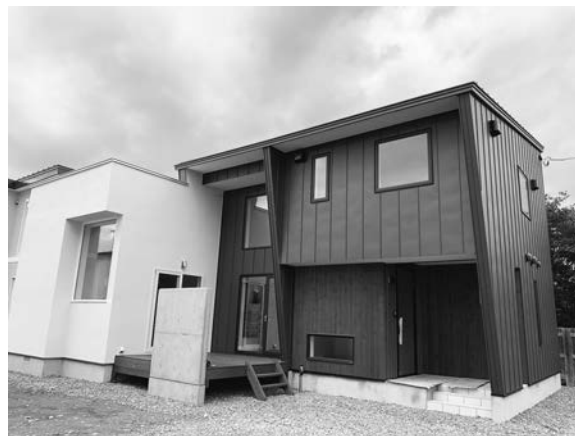
図表16 施工事例
