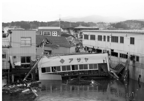
図表20 東日本大震災で被災した同社の本社(当時)
