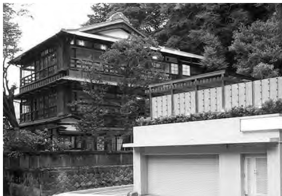
図表29 建物外観（別館）
