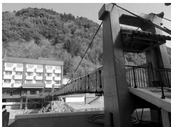
図表39 再建された赤いつり橋
