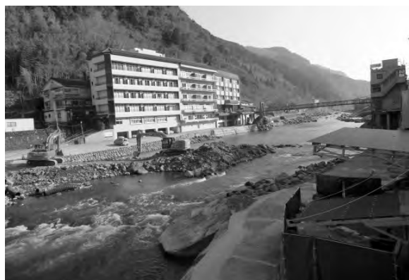
図表33 河川工事中の玖珠川の様子
