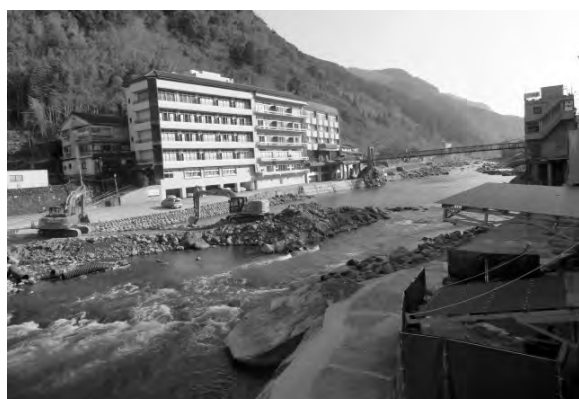
図表33 河川工事中の玖珠川の様子
