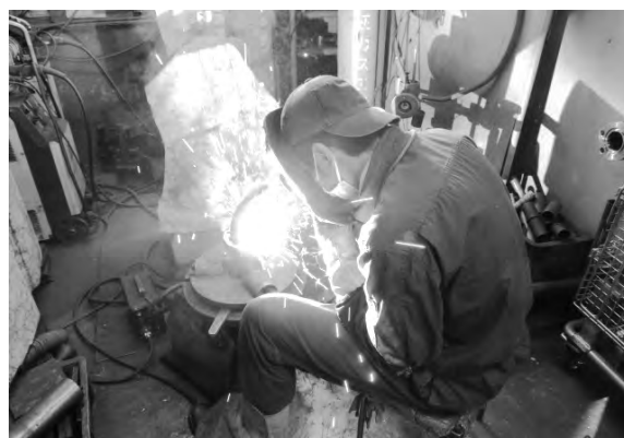
図表14 工場での作業風景
