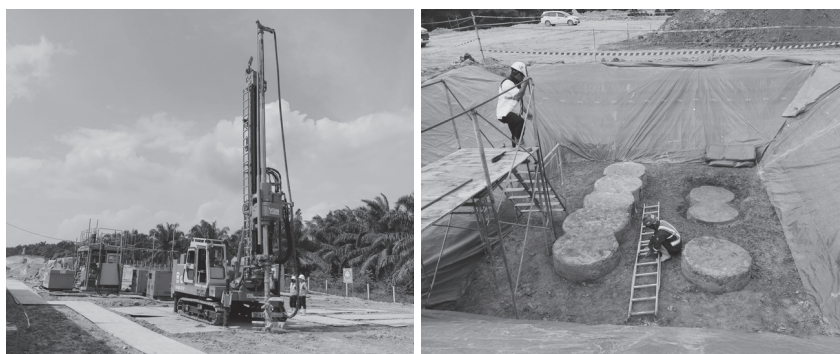
図表15 試験施工の現場
