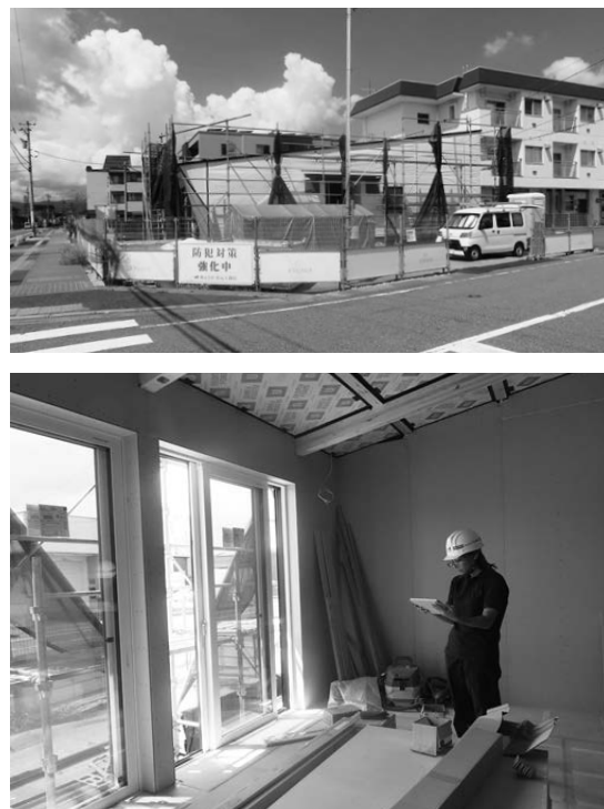
図表12 同社の住宅工事現場と「ANDPAD」活用風景
