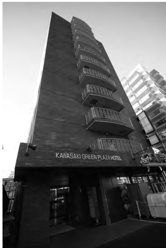
図表14 川崎グリーンプラザホテルの外観
