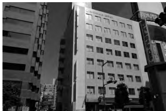
図表31 同社が入居する建物の外観
