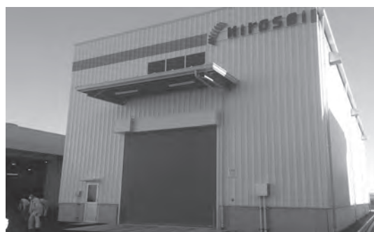
図表26 実験棟外観
