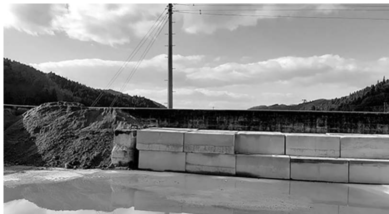
図表4 コンクリートブロック（余剰コンクリートのリサイクル）
