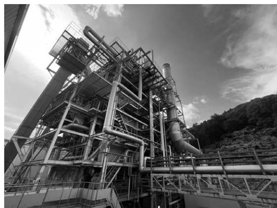
（備考）1. この中のボイラーで燃料が燃やされ、水を蒸気に変えている。
