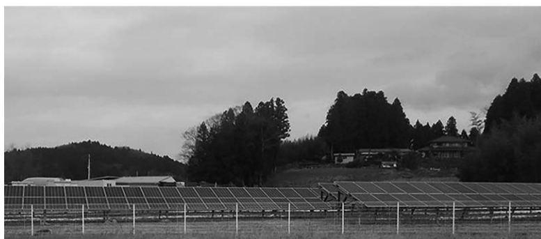
図表5 岩法寺太陽光発電所
