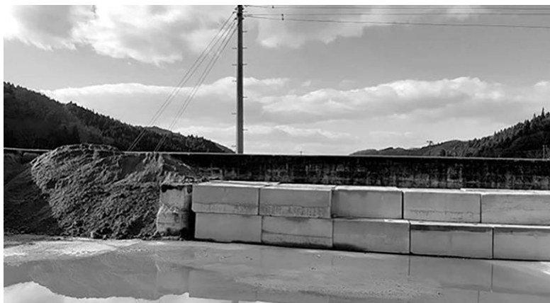
図表4 コンクリートブロック（余剰コンクリートのリサイクル）
