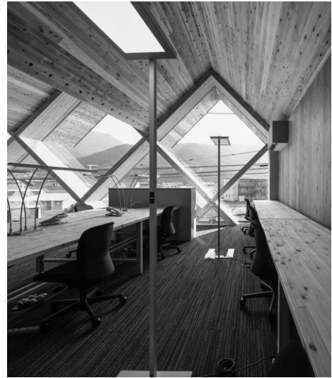
図表12 銘建工業本社内のCLTの壁
