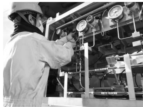
図表12 水素ステーションの保安検査
