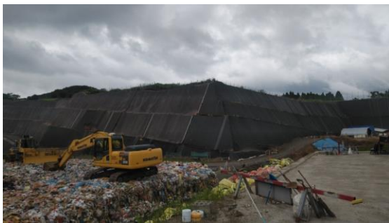
（図表12）ゴミの埋立処分場の状況
