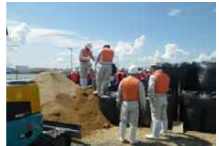
(図表10)大型土のう作成・配置現場
