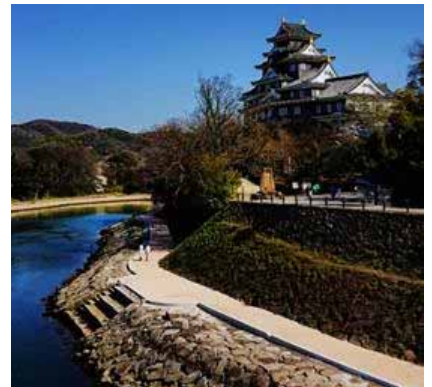
(図表7)旭川丸の内水辺整備工事
