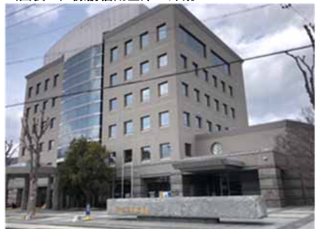
（図表8）諏訪信用金庫 外観
