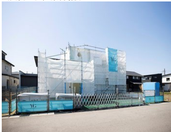
（図表20）建築現場例
