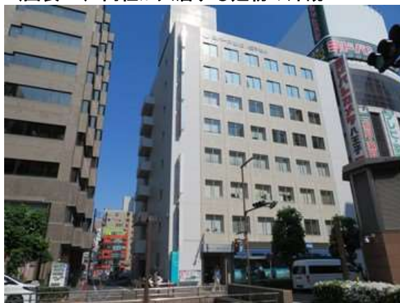
（図表 31） 同社が入居する建物の外観
