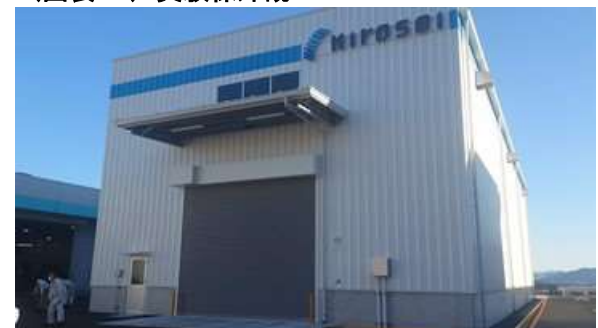
（図表 26） 実験棟外観
