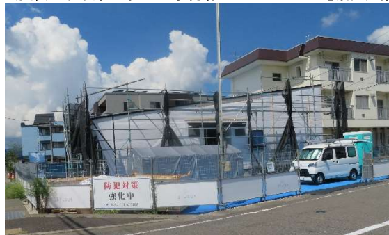
(図表12) 同社の住宅工事現場と「ANDPAD」活用風景
