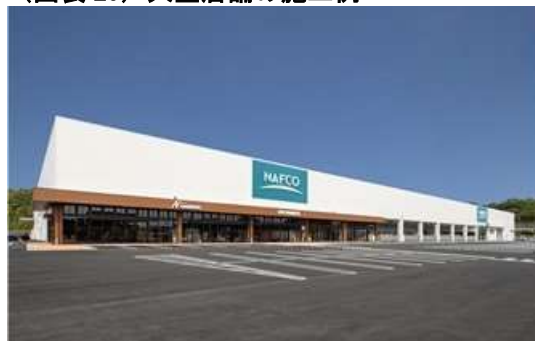
(図表 25) 大型店舗の施工例
