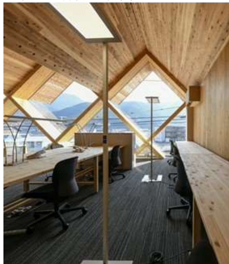
（図表 12） 銘建工業本社内のCLTの壁
