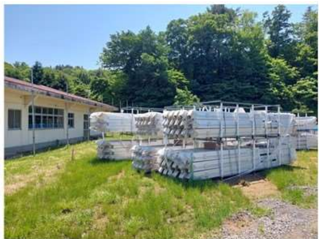
(図表13) 廃校のグラウンドに設置工事中の太陽光発電設備
