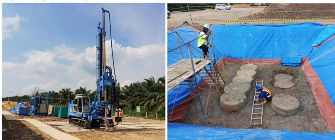
(図表4) 試験施工の現場
